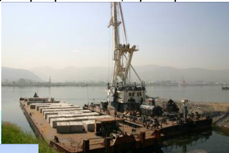
Разгрузка ж/б массивов
