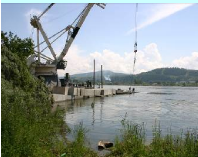
Объект выдержал напор Енисея в паводок 2006 года
