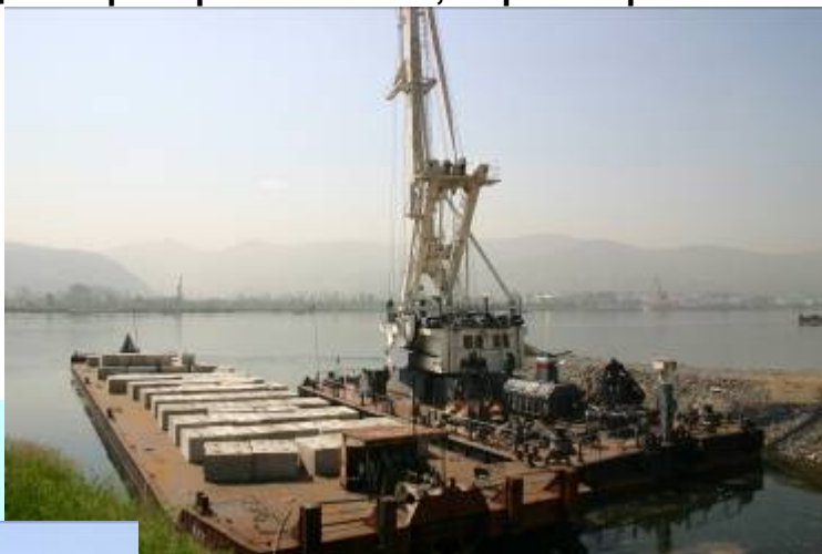
Разгрузка ж/б массивов
