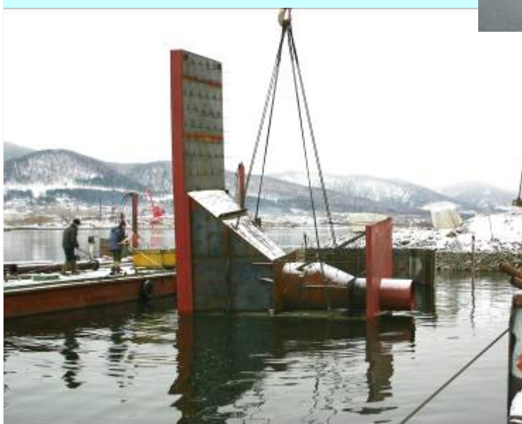
Монтаж конструкций оголовка руслового водозабора в подводное положение
