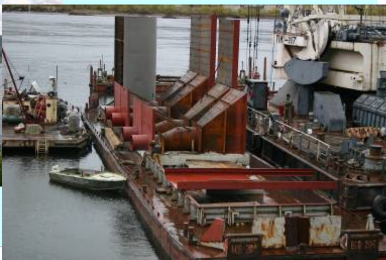
Сборка конструкций оголовка руслового водозабора
