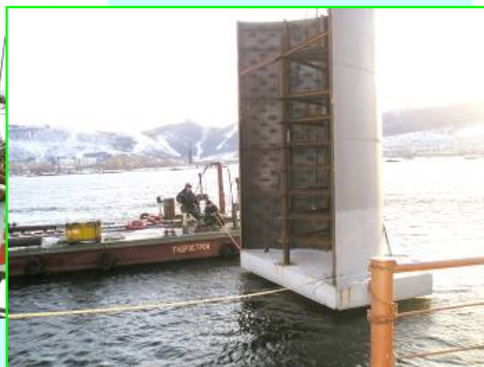
Сборка конструкций оголовка руслового водозабора
