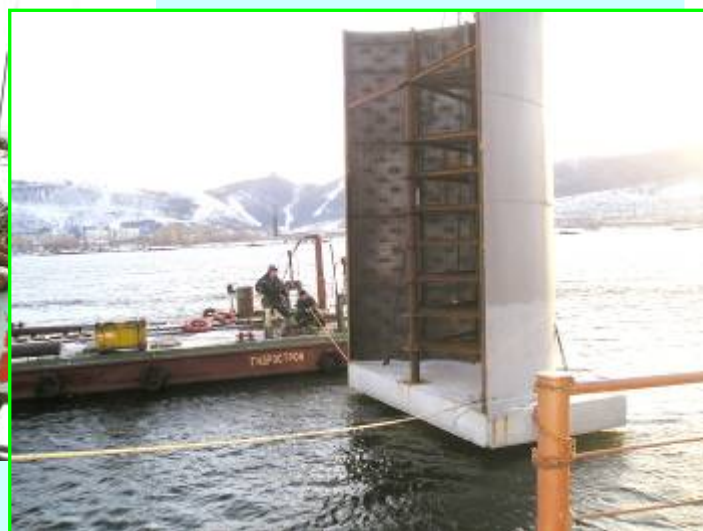
Сборка конструкций оголовка руслового водозабора
