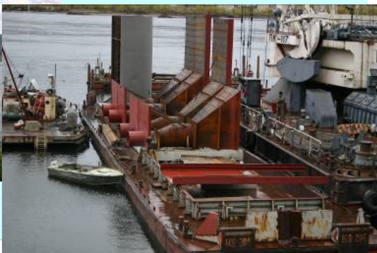
Сборка конструкций оголовка руслового водозабора
