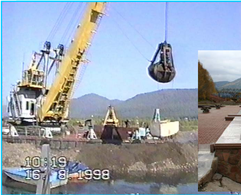
Строительство дамбы и причала на р.Мана и дамбы на р.Б-Веснина.
