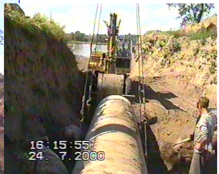
Строительство подводного трубопровода Д-1200 с десятью рассеивающими соплами в реке Енисей для г.Железногорска, весь комплекс работ был выполнен за два месяца.
