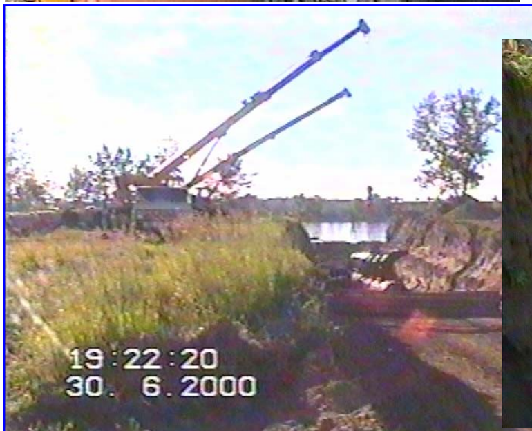
Строительство подводного трубопровода Д-1200 с десятью рассеивающими соплами в реке Енисей для г.Железногорска, весь комплекс работ был выполнен за два месяца.
