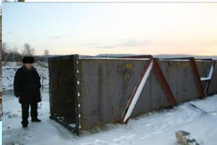
Проверка водоводов пропуска строительных расходов
