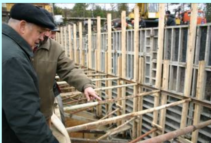
Контроль устройства опалубки для бетонирования водобойного колодца.
