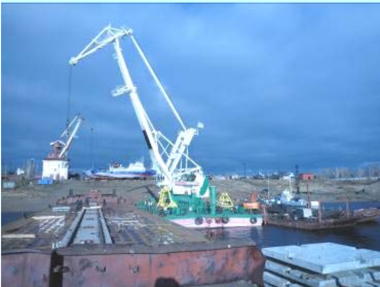
Обкатка спусковой дорожки грузом 140 т
