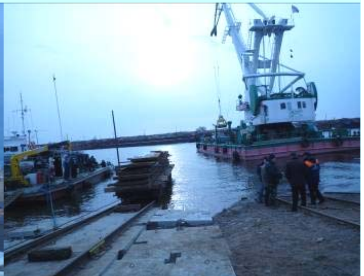
Обкатка спусковой дорожки грузом 140 т
