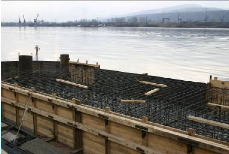
Армирование и установка закладных деталей оголовка
