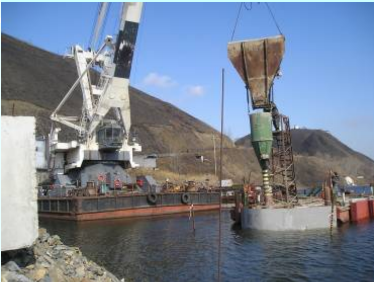
Бетонирование водоприемного оголовка методом ВПТ
