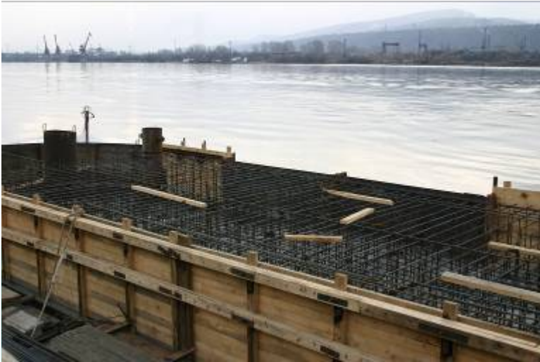
Армирование и установка закладных деталей оголовка
