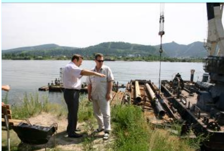
Ген.директор ООО «Краском» Матюшенко А.И. контролирует ход строительства.
