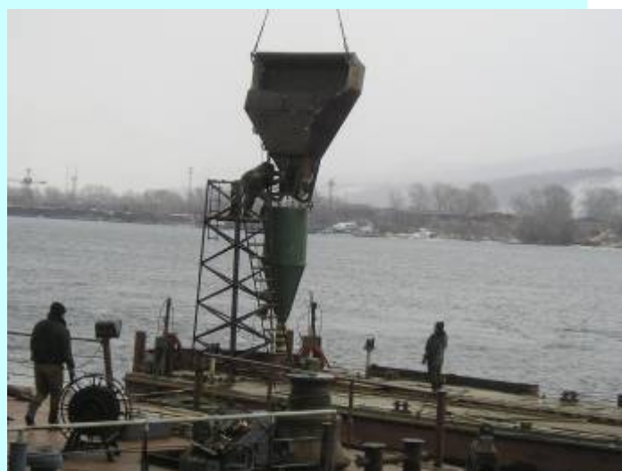
Подводное бетонирование оголовка методом ВПТ.
