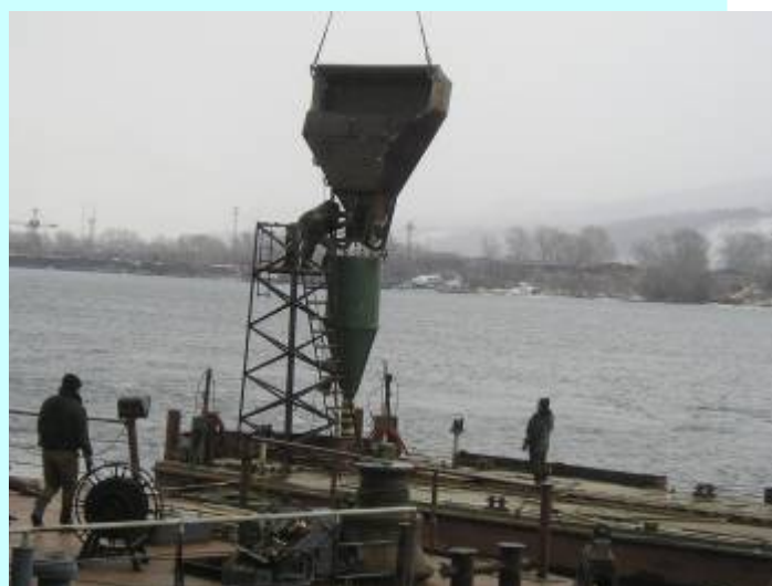
Подводное бетонирование оголовка методом ВПТ.
