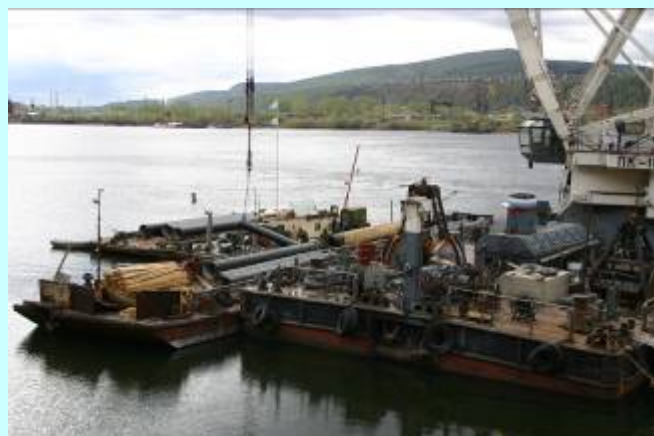
Монтаж трубопроводов в подводное положение и стыковка с водоприемными камерами БНС.
