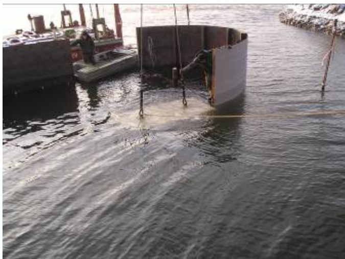
Укладка бетонных массивов под воду
