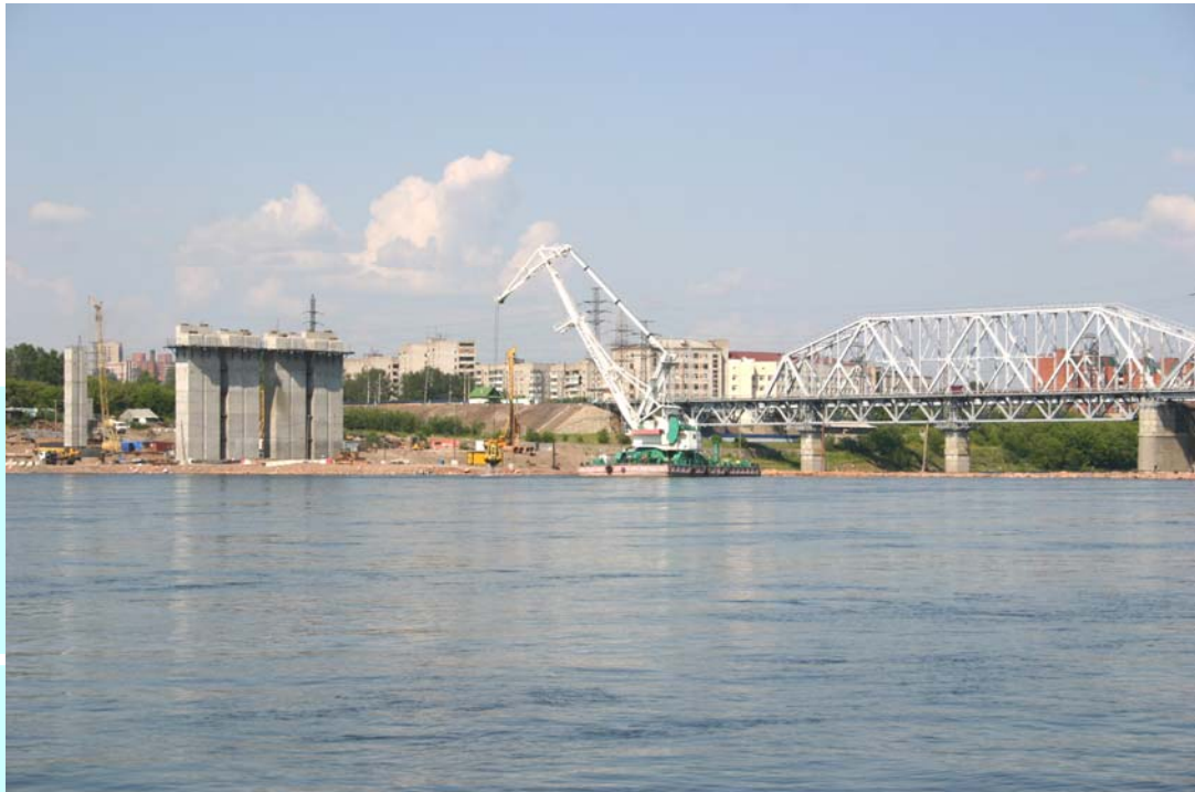
Вид на левобережный участок строительства моста
