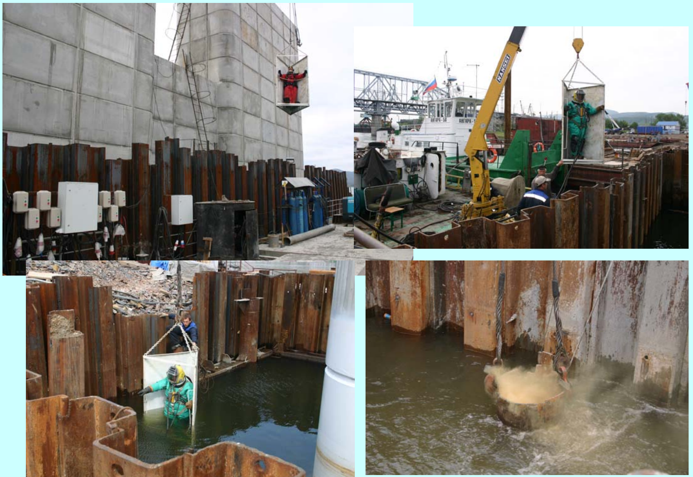
Водолазы выполняют работы по подводной срезке металлоконструкций в районе опор
