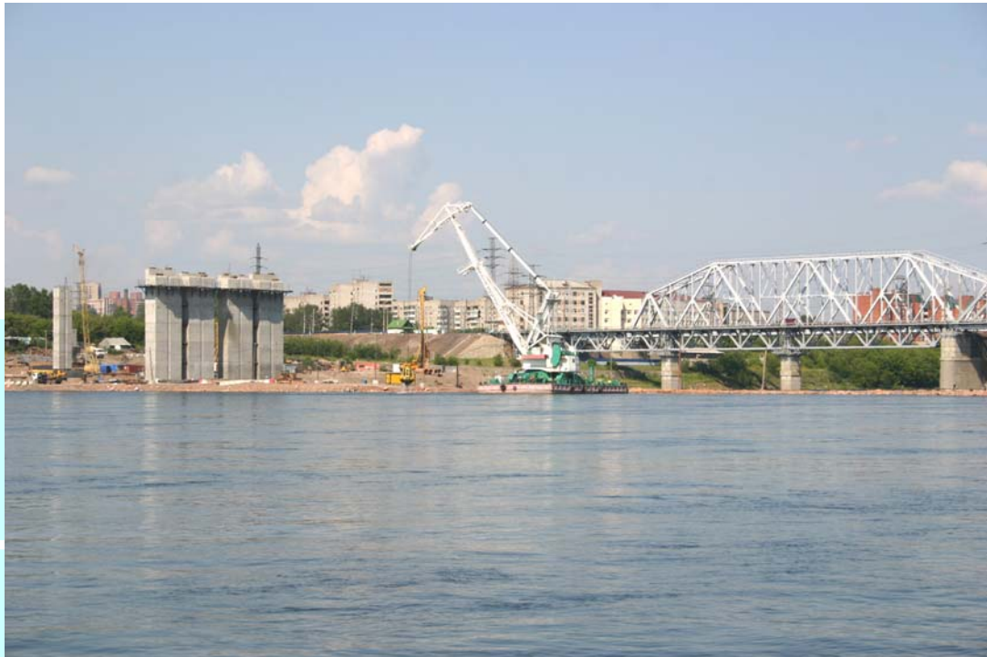
Вид на левобережный участок строительства моста
