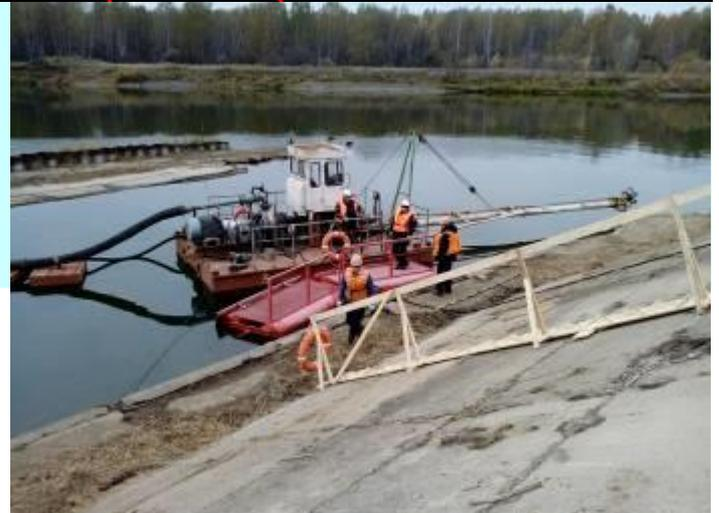
Обследование БНС и рассеивающего выпуска на р.Чулым. Очистка ковша и водоприемных камер от иловых отложений, очистка кассет рассеивающего выпуска.
