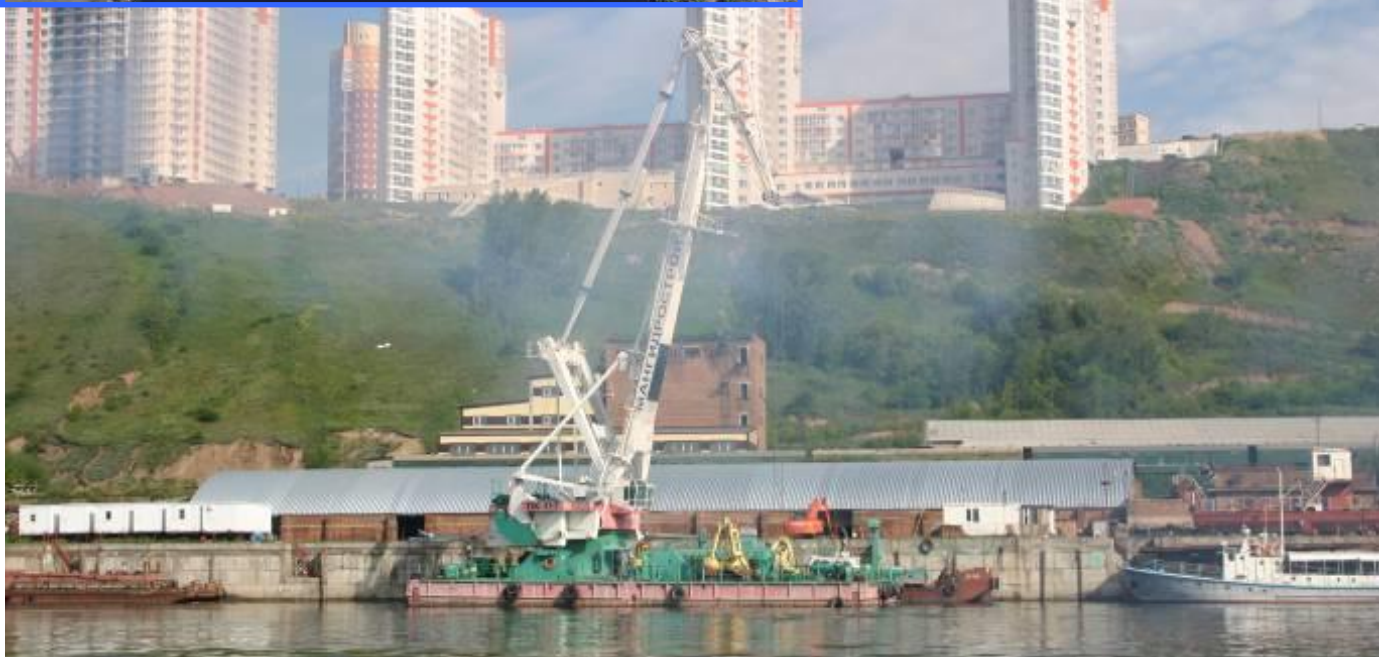
Транспортно-производственная база и причал L=300 м с подъездными железнодорожными путями, расположена в г. Красноярске на левом берегу р.Енисей.
